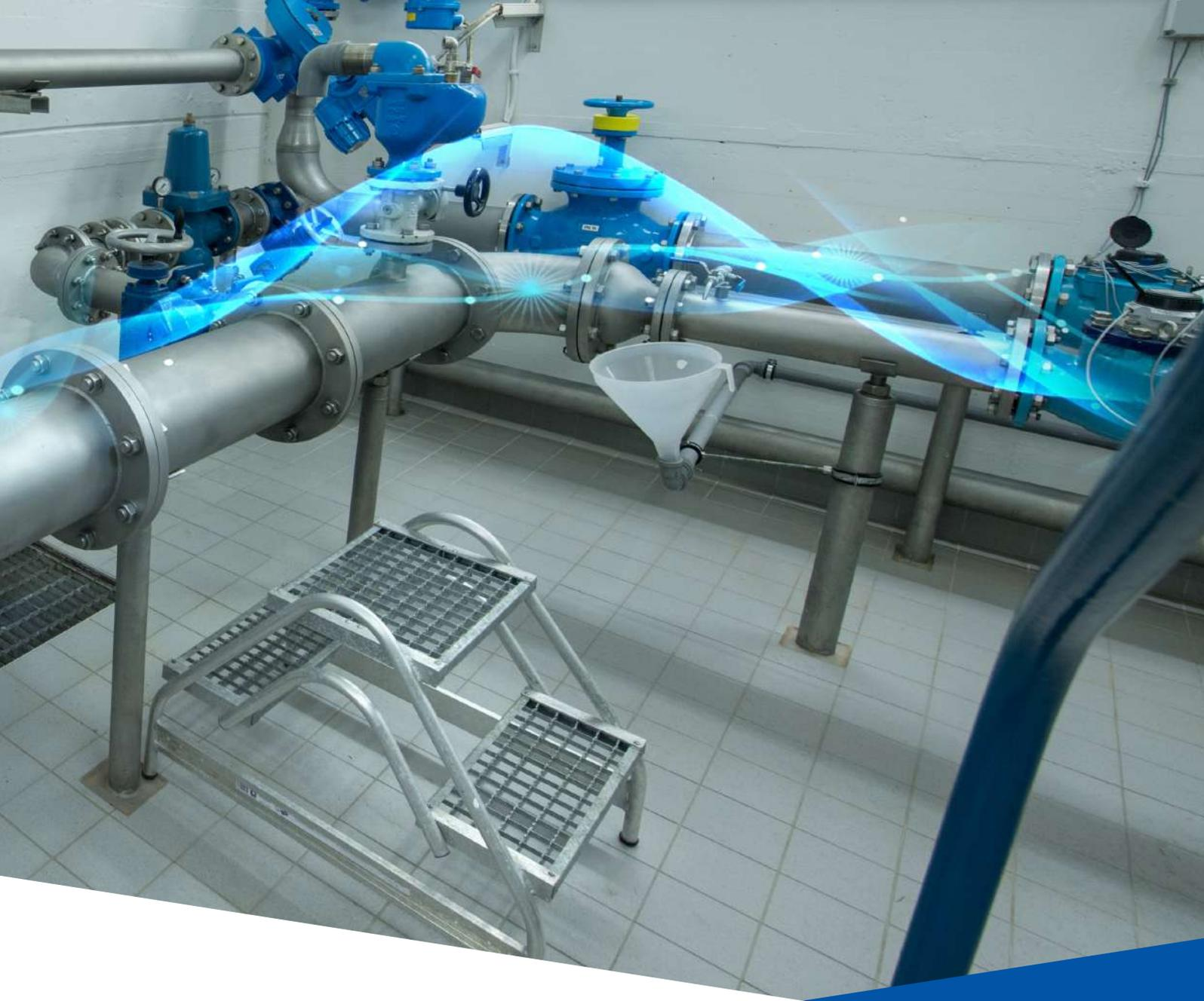
**Stationäre Ultraschallmessgeräte** sind ideal geeignet zur messtechnischen Überwachung von Trinkwassernetzen. Die Installation erfordert keinerlei Eingriff in die Rohrleitung. Dies ermöglicht die einfache und kosteneffiziente Einrichtung zusätzlicher Durchflussmessstellen in einem bestehenden Trinkwasserversorgungsnetz.
